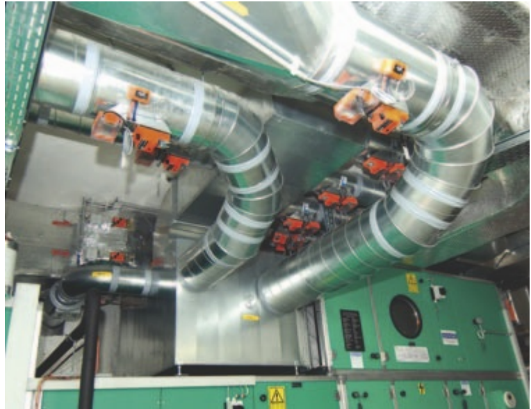
VAV-Boxen ohne Schalldämpfer.
